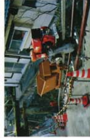
▲支持台利用方式(傾斜地、右側に設置)
