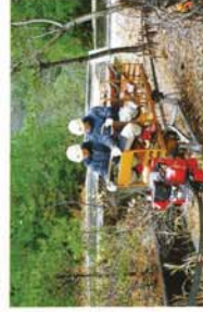
▲支柱打ち込み方式(中掘地・車輪架設式専用モノレール)
