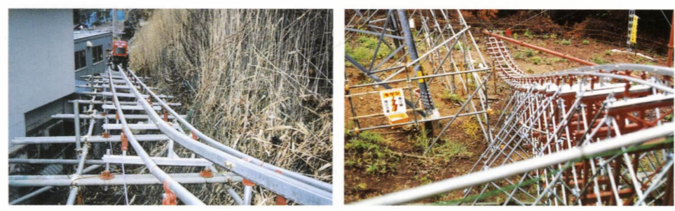
※狭あいな法面の横断(北海道) 家屋の裏の法面工事は、モノレールルートの起点のスペースがないことが多い、単管足場の上に簡単に設置出来、大量運搬を可能にします。 ※高架工事(愛知県) 自然の凸凹・河川横断、上記の現場のように番台にセットする場合等は、当社3条式支持台及び高架枠を使えば、足場材なしでも設置可能です。又足場材の上にも設置出来ます。
